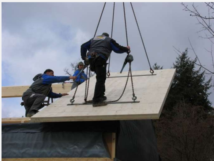
Монтаж на покривни панели
