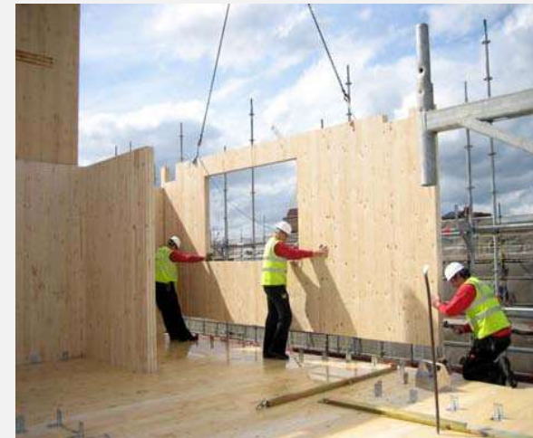
Монтаж на стенни панели
