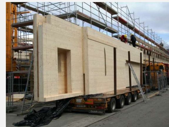
Разтоварване на строителната площадка
