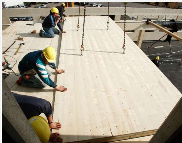
Монтаж на подови панели
