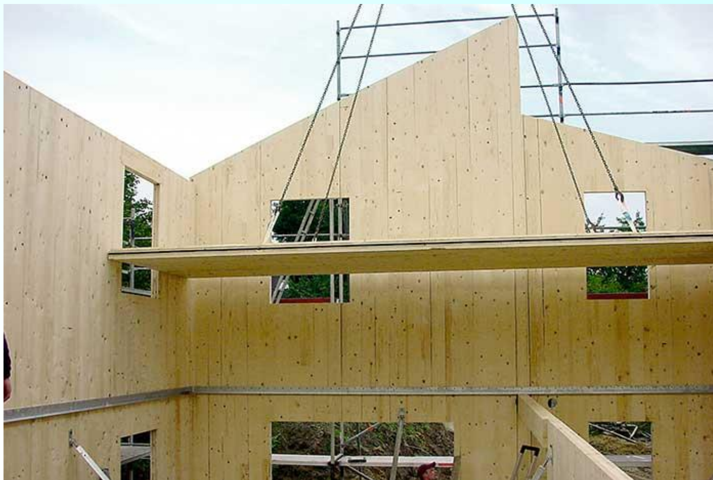
Етажна сграда от ПОСД в процес на строителство
