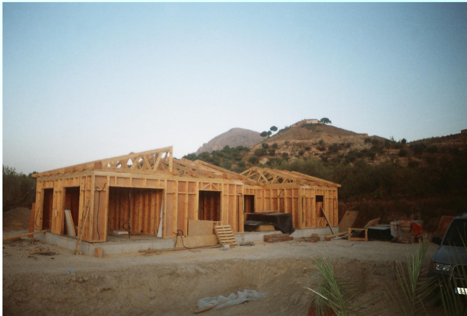
Завършен скелет и покрив – източник инж. Спас Чуканов
