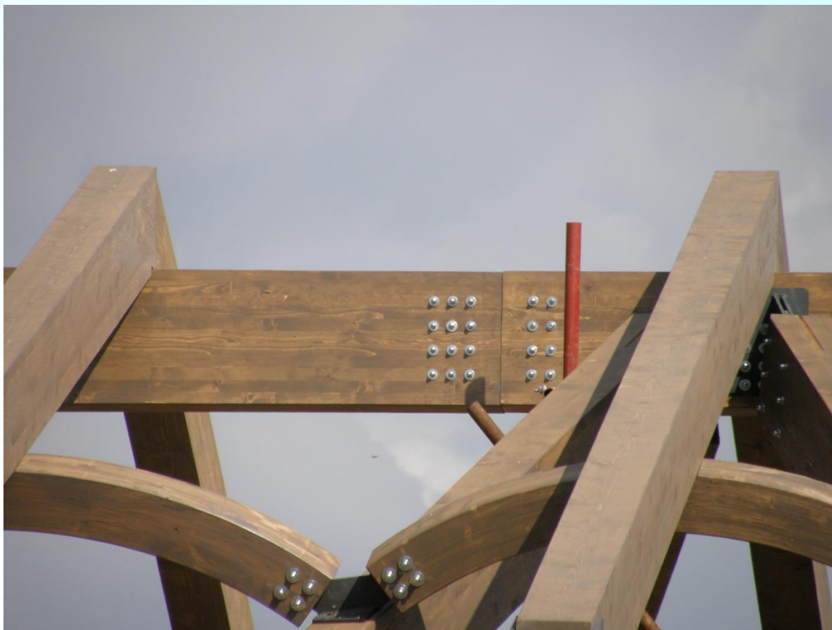
В Напречно сечение със стоманени шпилки
