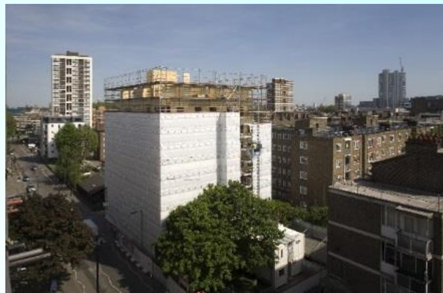
Етажни сгради от ПОСД в процес на строителство
