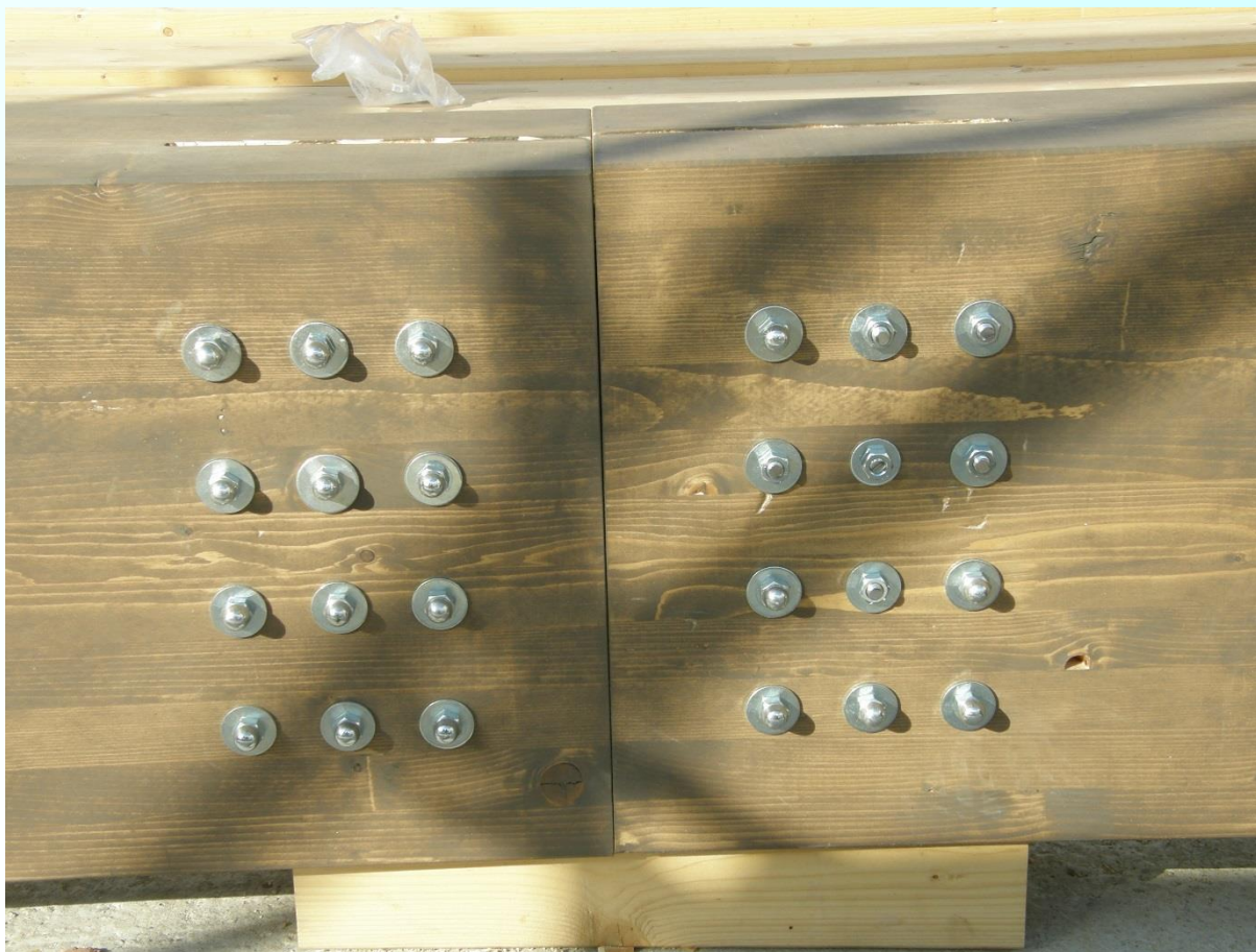
В Напречно сечение със стоманени шпилки
