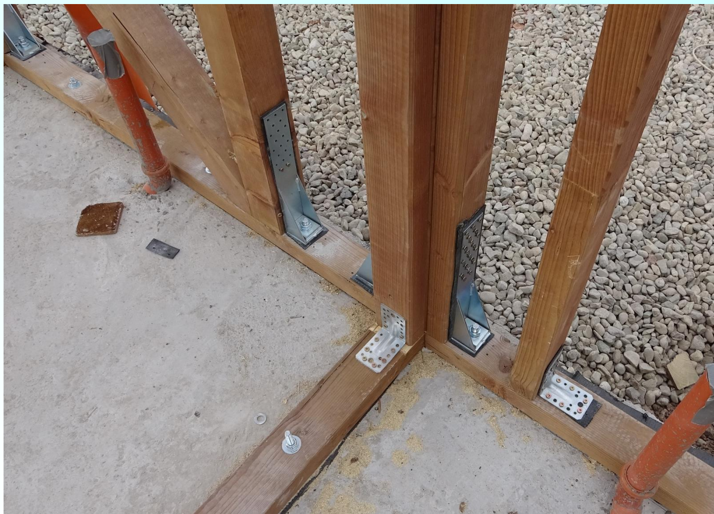
Детайли за анкериране на крайни стойки
